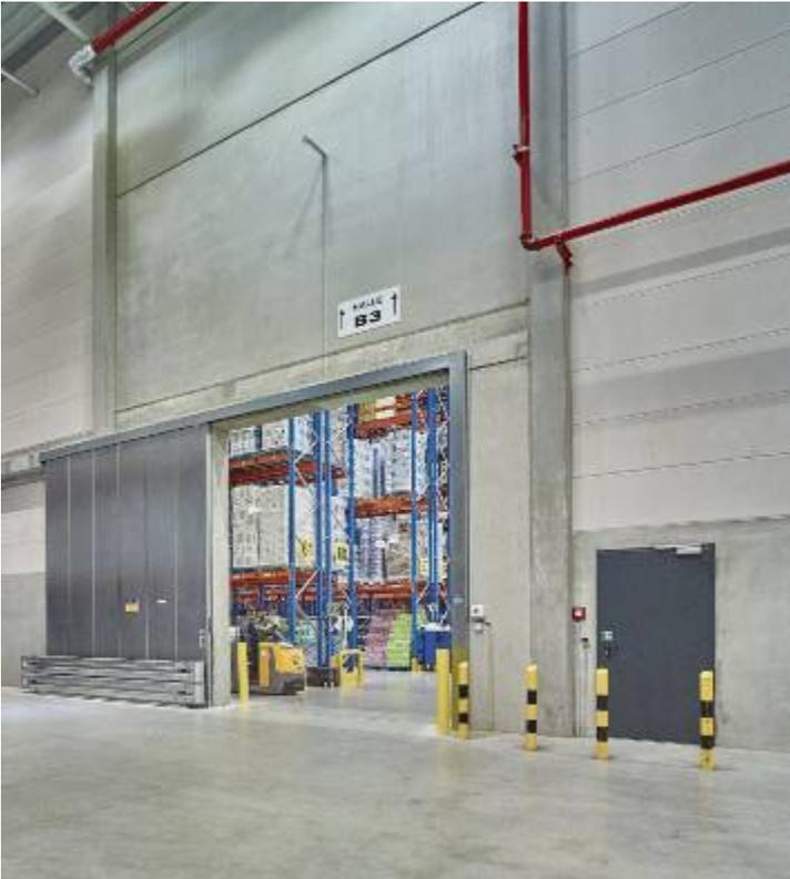
**Figura 10:** in caso d'incendio, 58 portoni tagliafuoco scorrevoli ad un battente Hörmann di tipo FST 90-1 garantiscono la sicurezza. La porta antincendio laterale assicura la via di fuga alle persone che si trovano all'interno dell'edificio.
