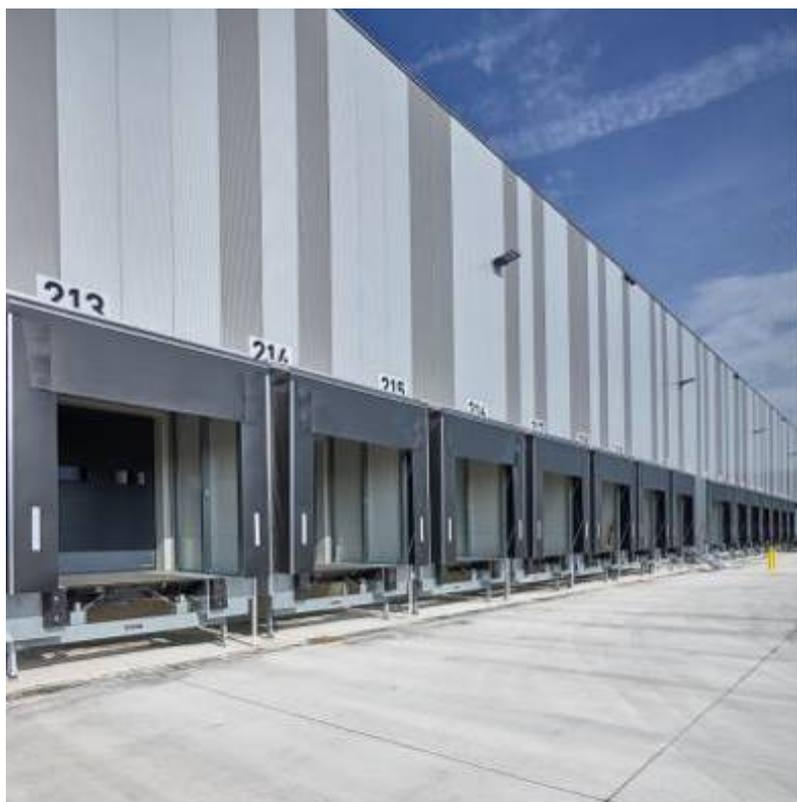
**Figura 5:** per il parco logistico di Metro, Hörmann ha fornito, oltre ad altre soluzioni, 407 porte sezionali industriali con pedane di carico e boccaporti prefabbricati.
